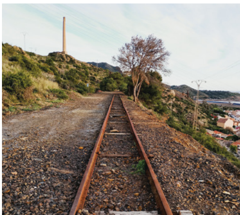
Tramo de vía férrea fuera del Túnel José Maestre. La Unión. Autor: Fundación Sierra Minera.
